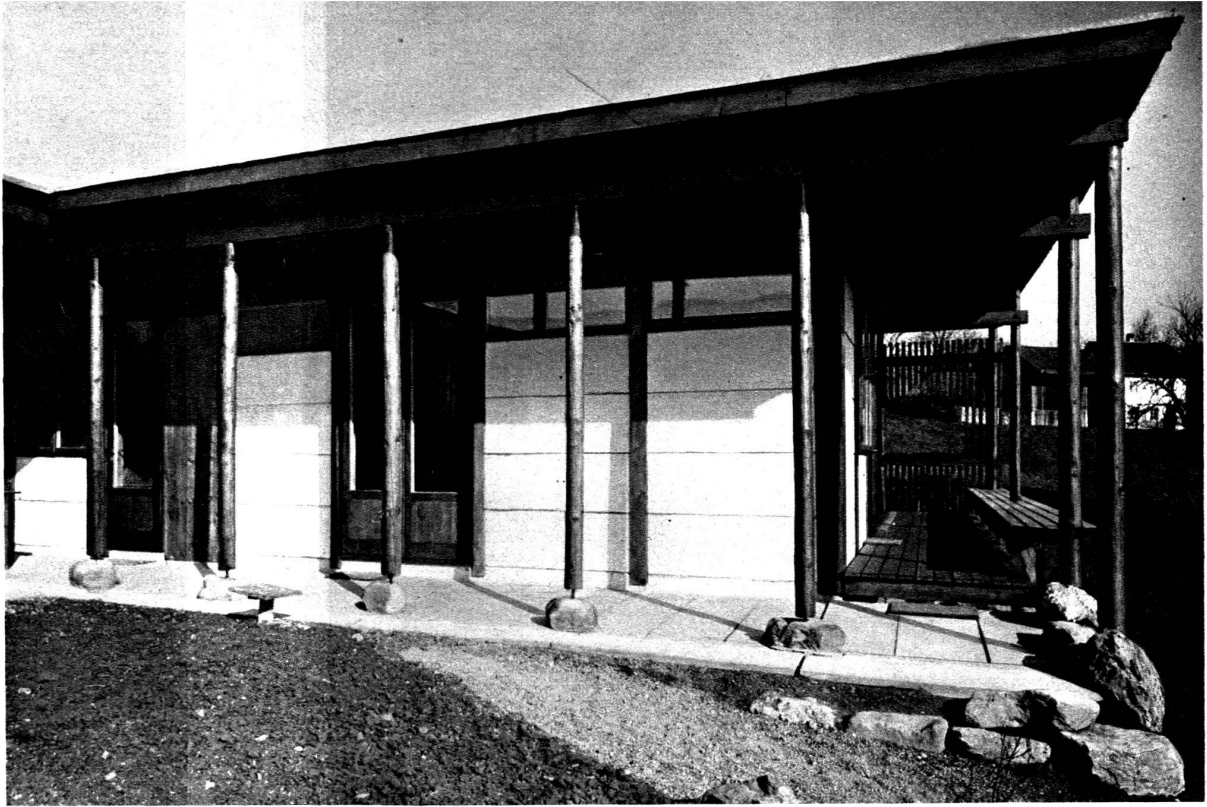
Angle sud ouest avec les portes de la cuisine et de la salle à manger.
