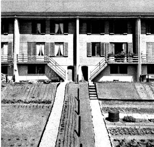
Façade sud groupe II, détail.
