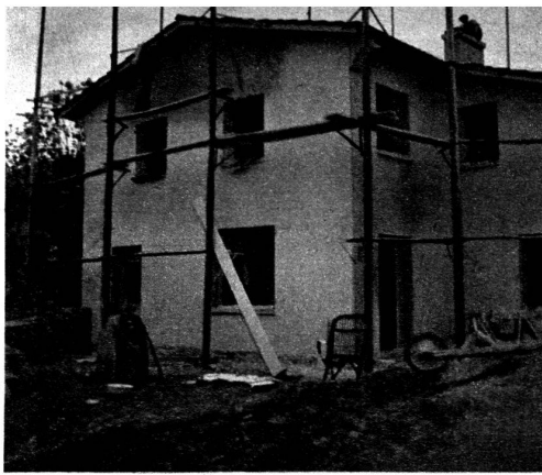
Jointoyages et crépissages
