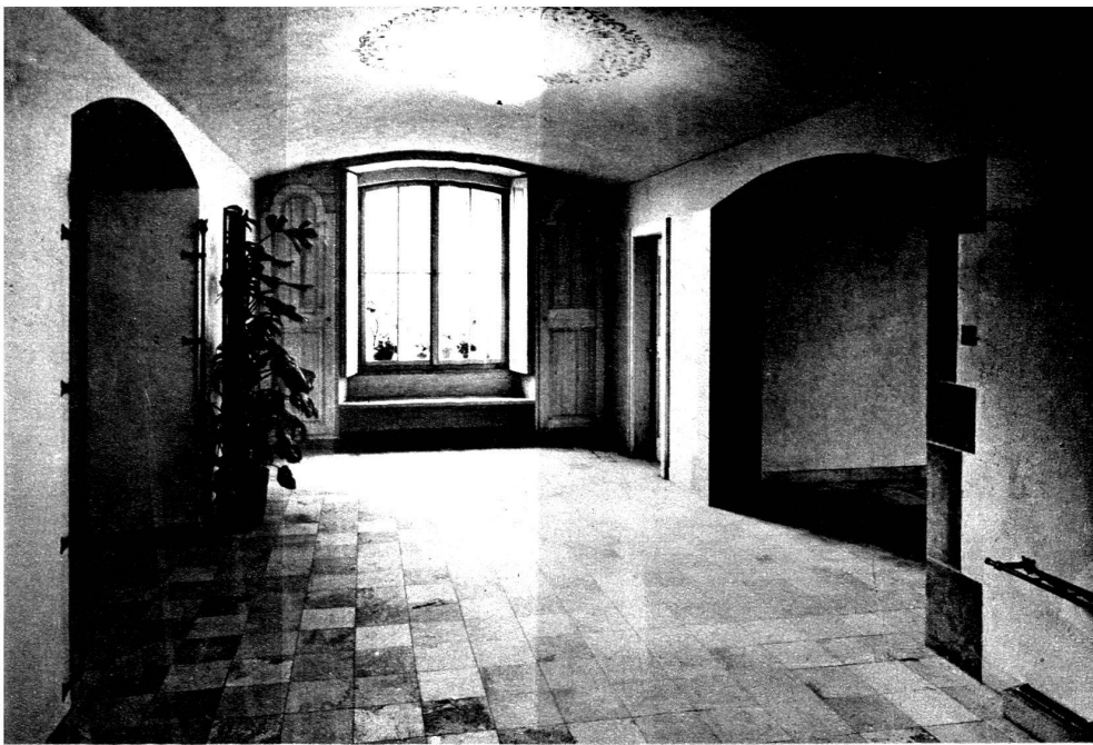
Vestibule d'entrée : sols en carreaux de Solnhofen, menuiseries en sapin naturel.
