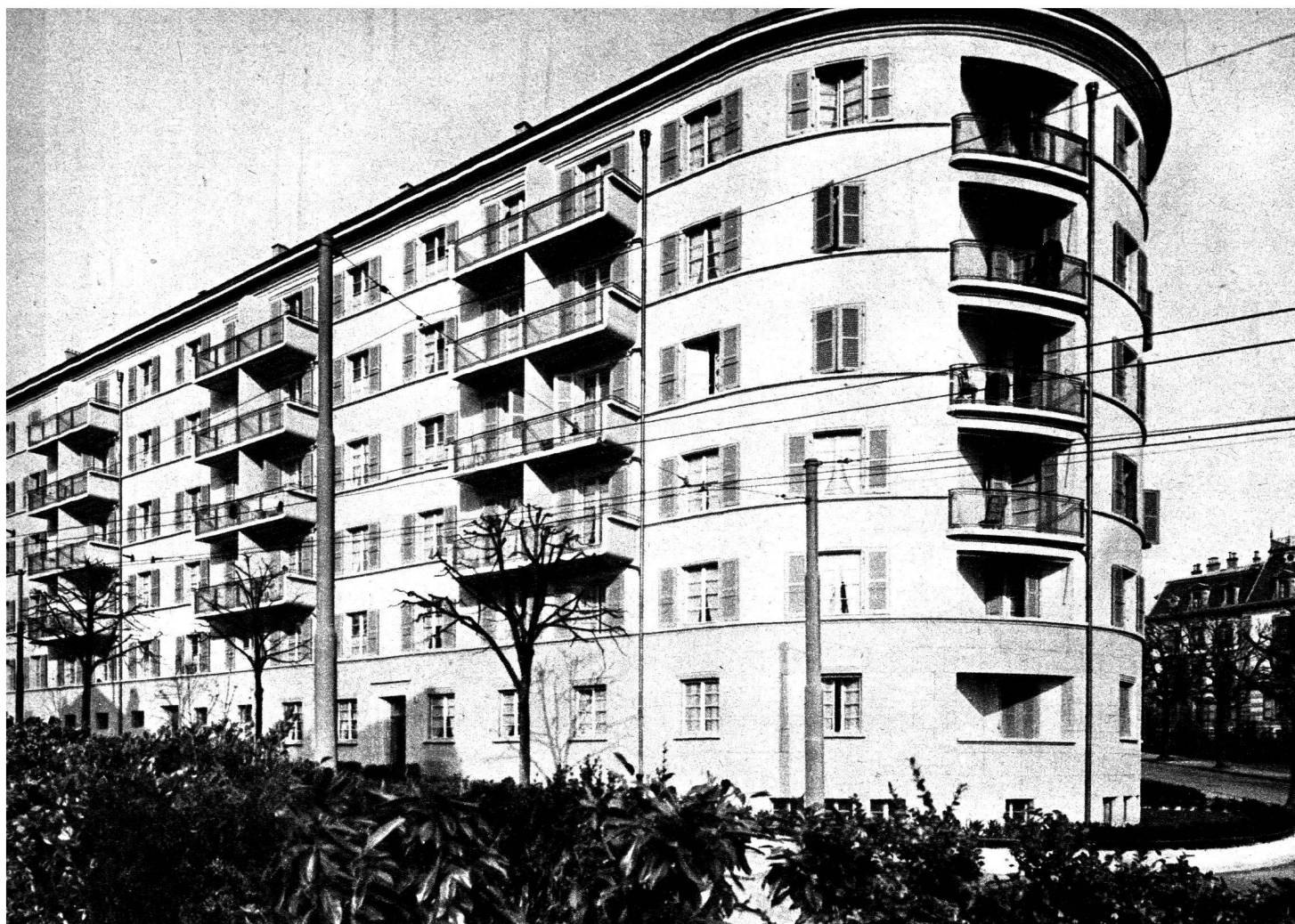
1933 Les maisons du second groupe d'habitations du Pré-d'Ouchy dépassent de trois étages leurs voisins de 1923. (Société coopérative d'habitation, Lausanne.)
