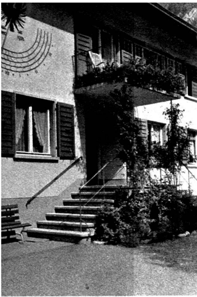
Maison de vieillesse de Meiringen. L'entrée principale avec l'aigle béraldique.
