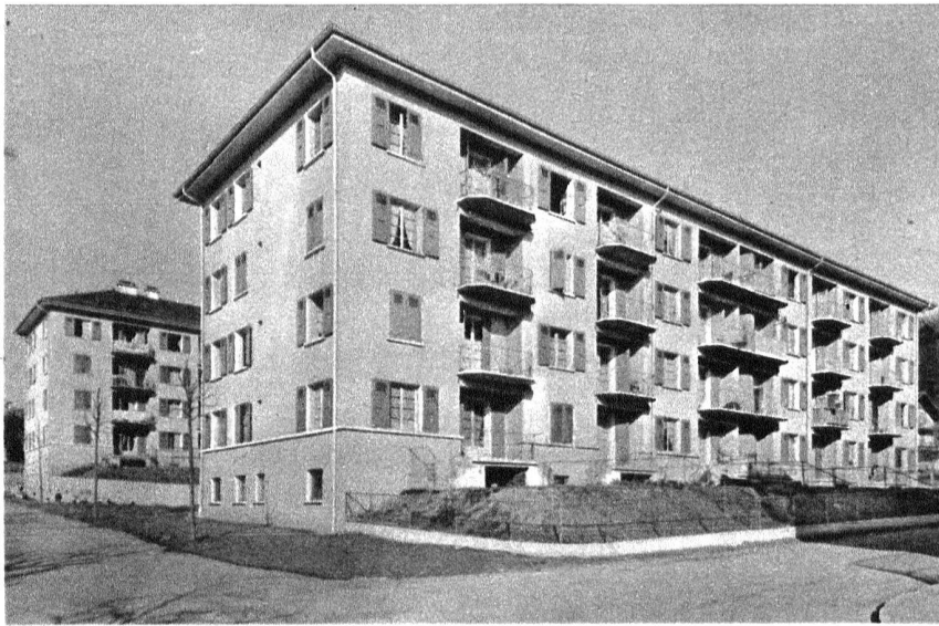
Groupe de Bellevaux. Vue prise du sud-ouest.
