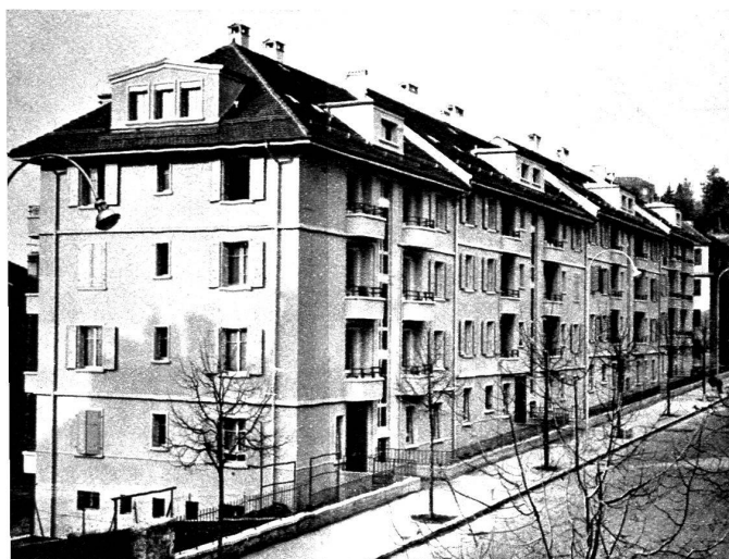
Groupe Marc-Dufour - Façade nord (Photo H. Chappuis, Pully-Nord).
