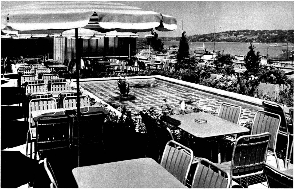
La terrasse sur toiture avec vue sur la rade. Une dalle en béton translucide éclairant l'escalier du magasin est utilisée comme bassin d'agrément. (Photo M. Kettel, Genève.)
