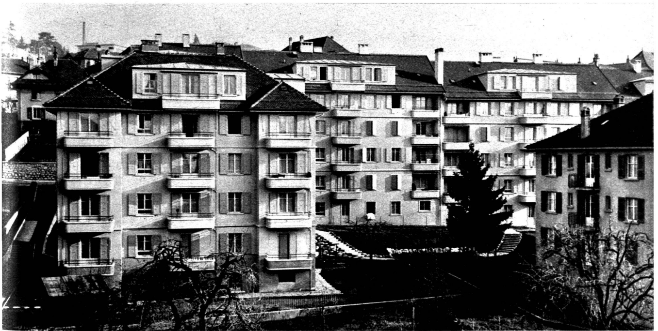
Grupe Marc-Dufour - Façades sud (Photo H. Chappuis, Pully-Nord).
