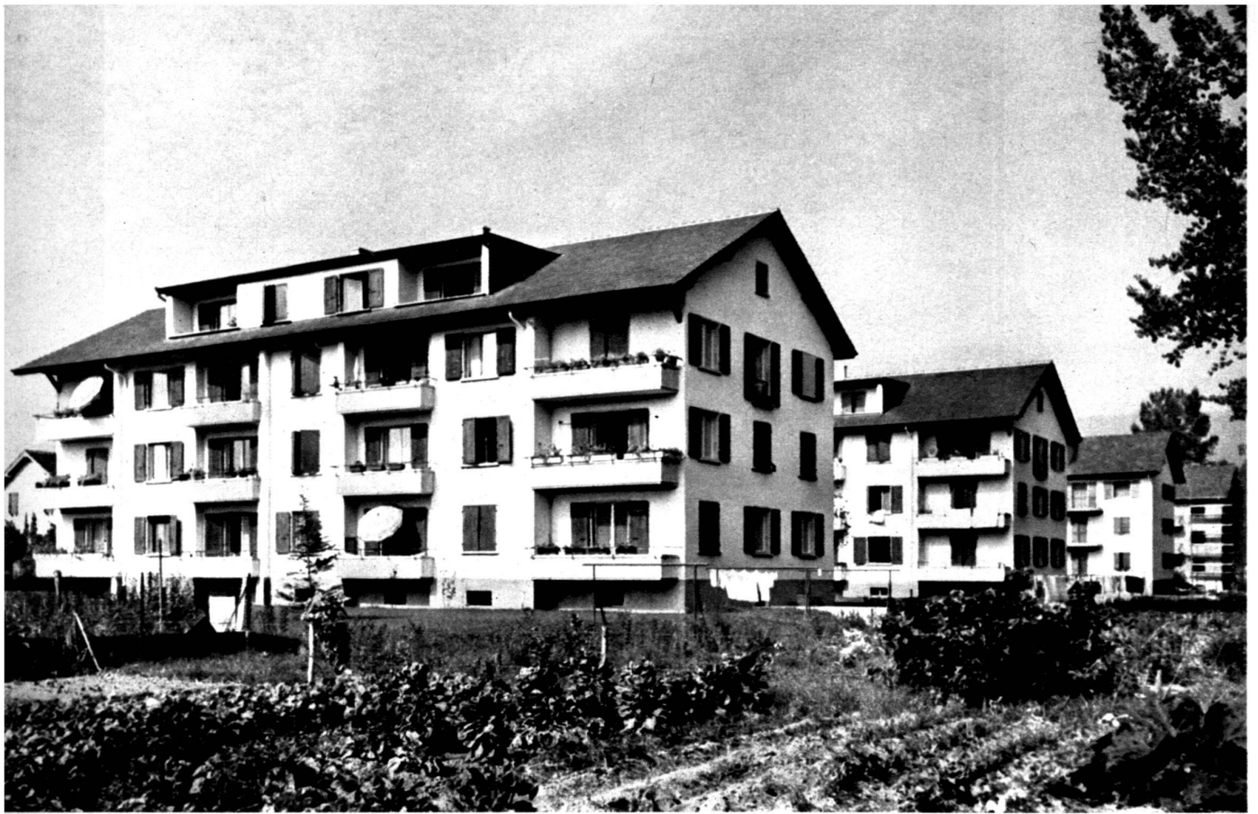
Vue générale de la cité d'habitation.
