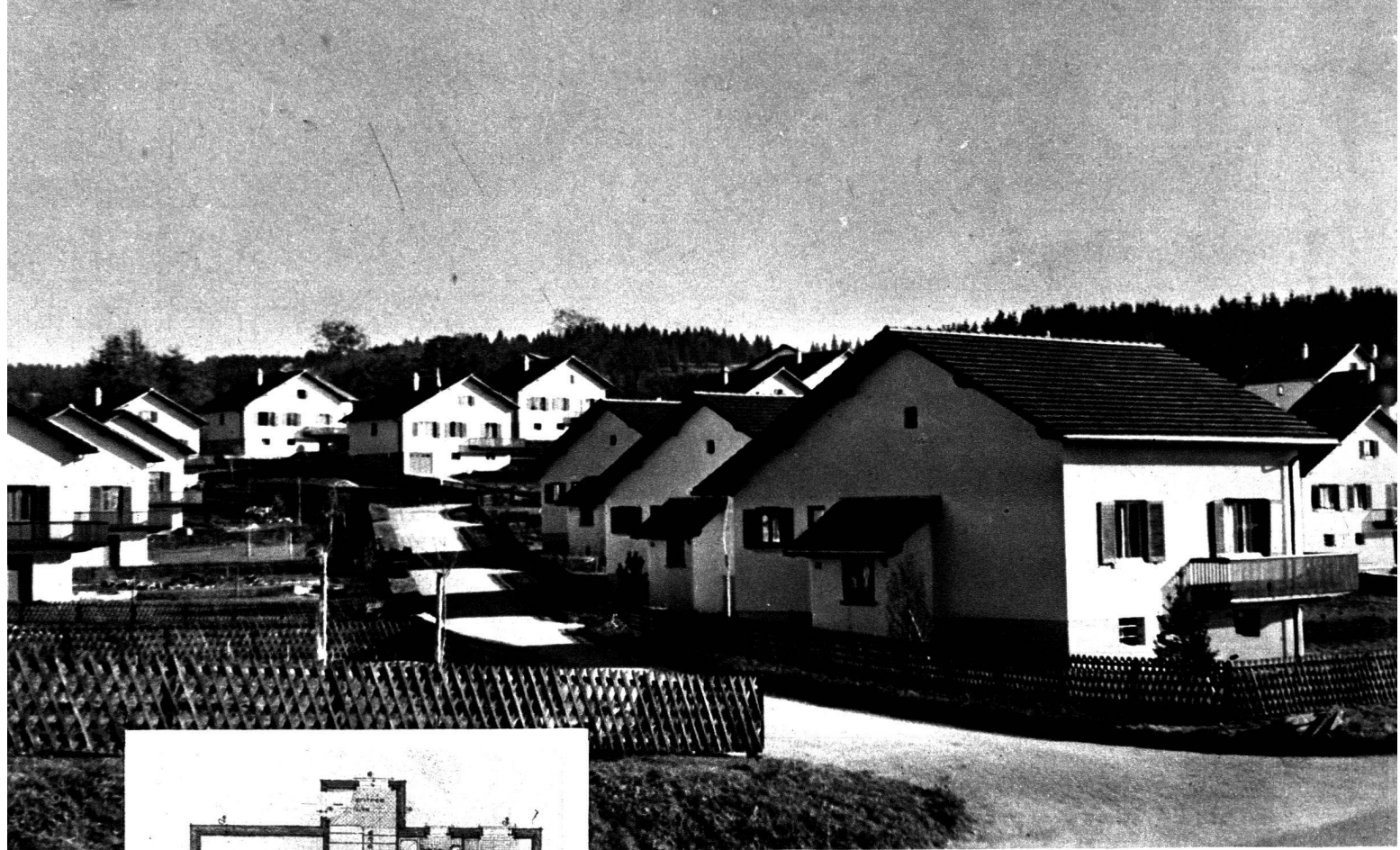
(Photos F. Perret.)
