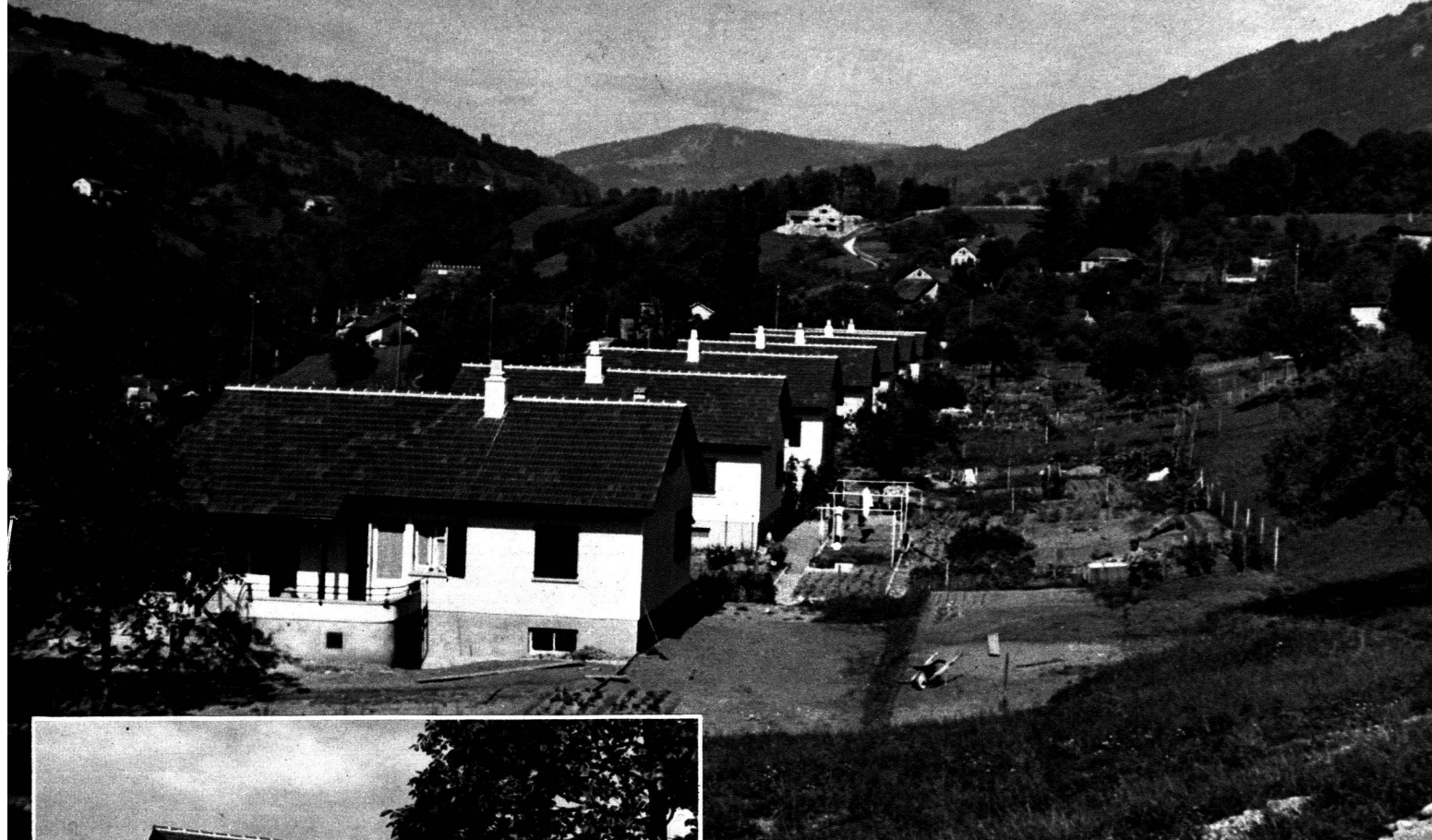
Vue générale du groupe.
