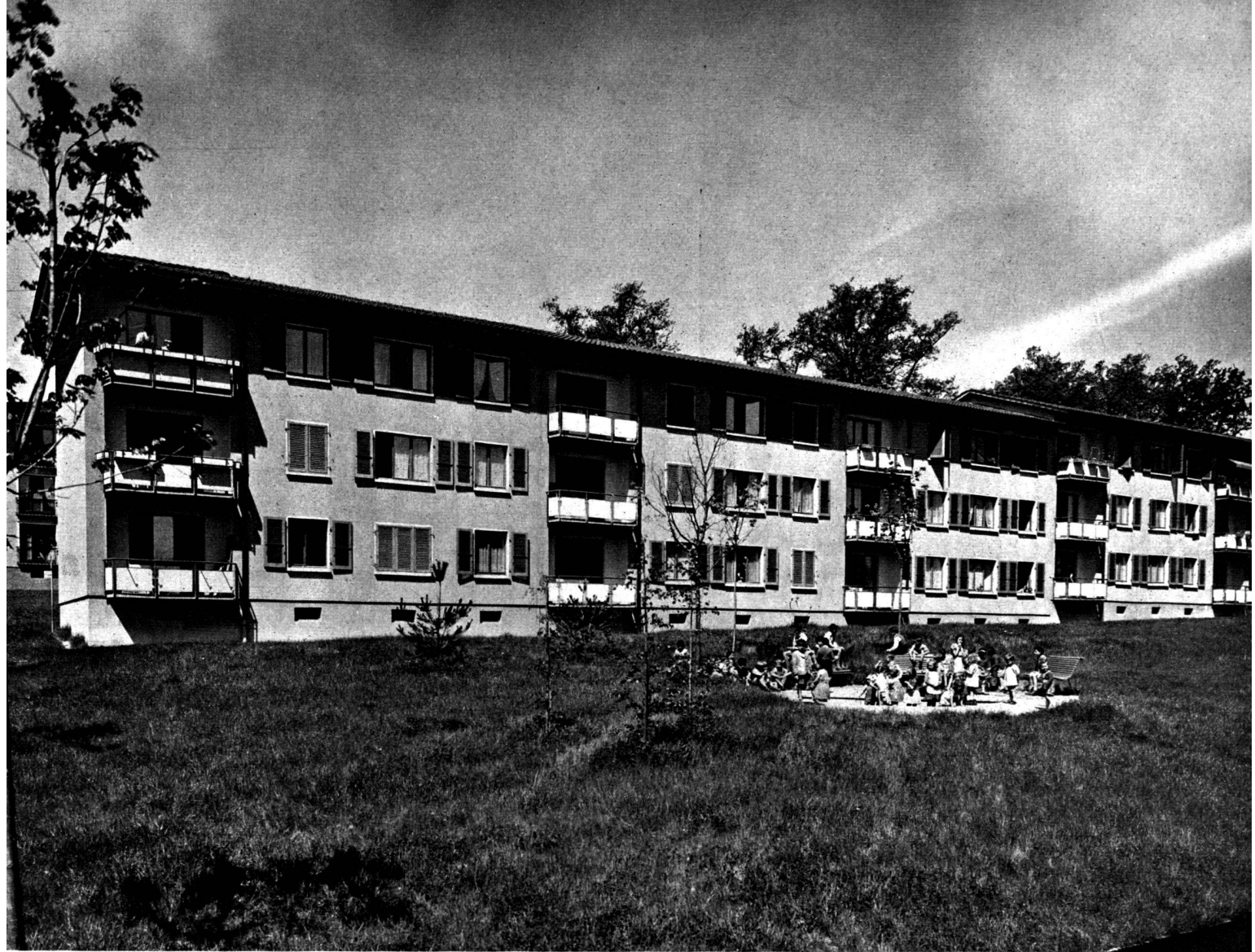
Un bâtiment de la première étape de Villars, vu du sud-est.
