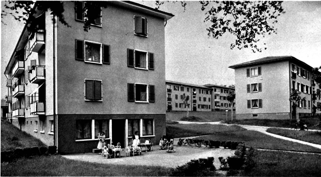
Ci-contre : Le bâtiment P et la garderie d'enfants.
