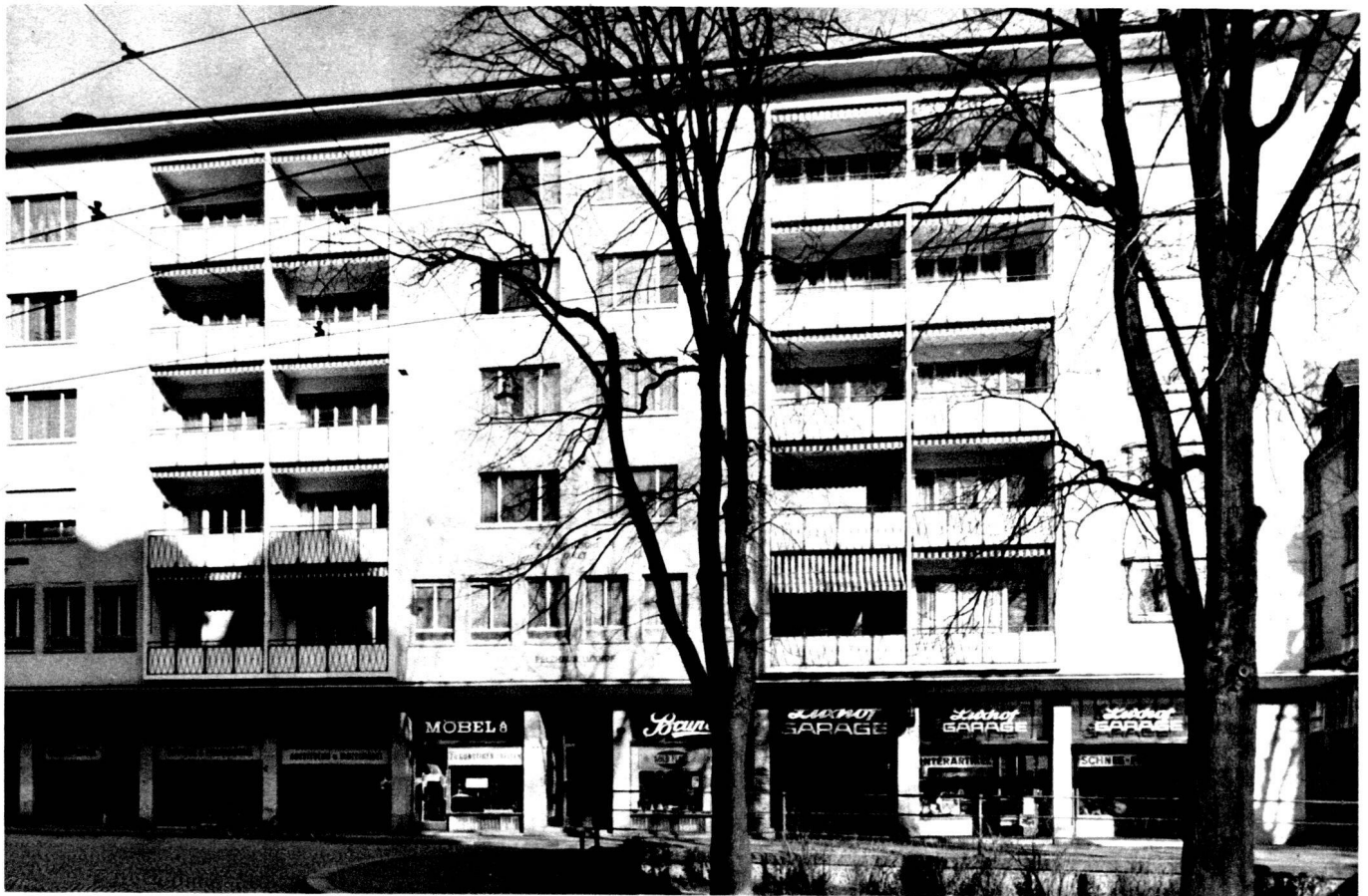
10. Immobiliengesellschaft Schimmelhof AG., Zürich, Wohn- und Geschäftshaus «Luxhof», Beckenhofstrasse 70/2, Zürich 6. Arch.: O. Becherer, W. Frey & R. Schneider, Zürich (1947/48). Immeuble locatif et d'affaires «Luxhof», Beckenhofstrasse 70/2, Zurich.
