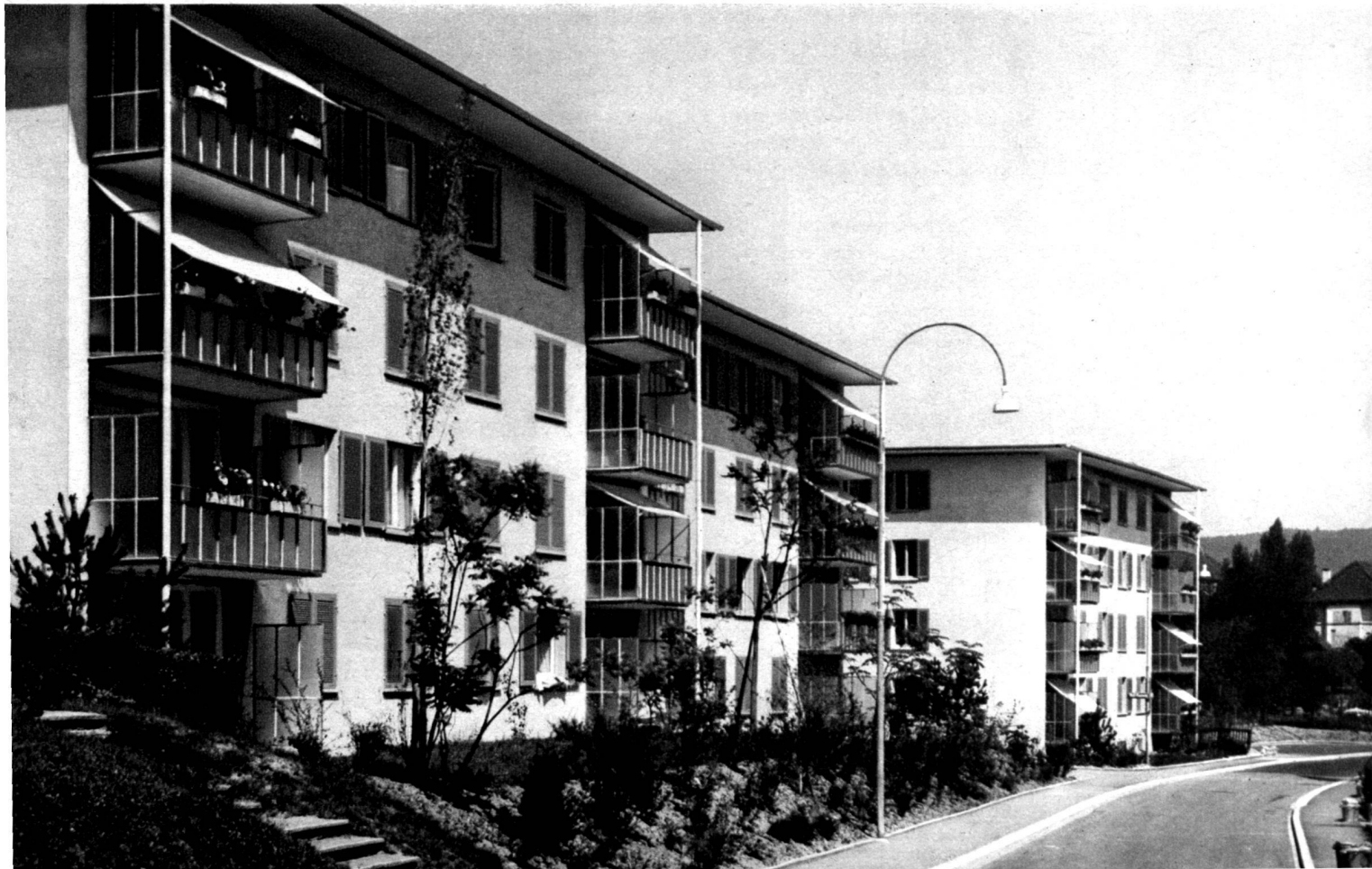
19. Allgemeine Baugenossenschaft Zürich, Mehrfamilienhäuser am Waidfussweg, Zürich 10 (2. Etappe). Arch. : Prof. Dr. H. Hofmann, Zürich (1949/50). Maisons pour plusieurs familles au Waidfussweg, Zurich 10 (2 e étape).
