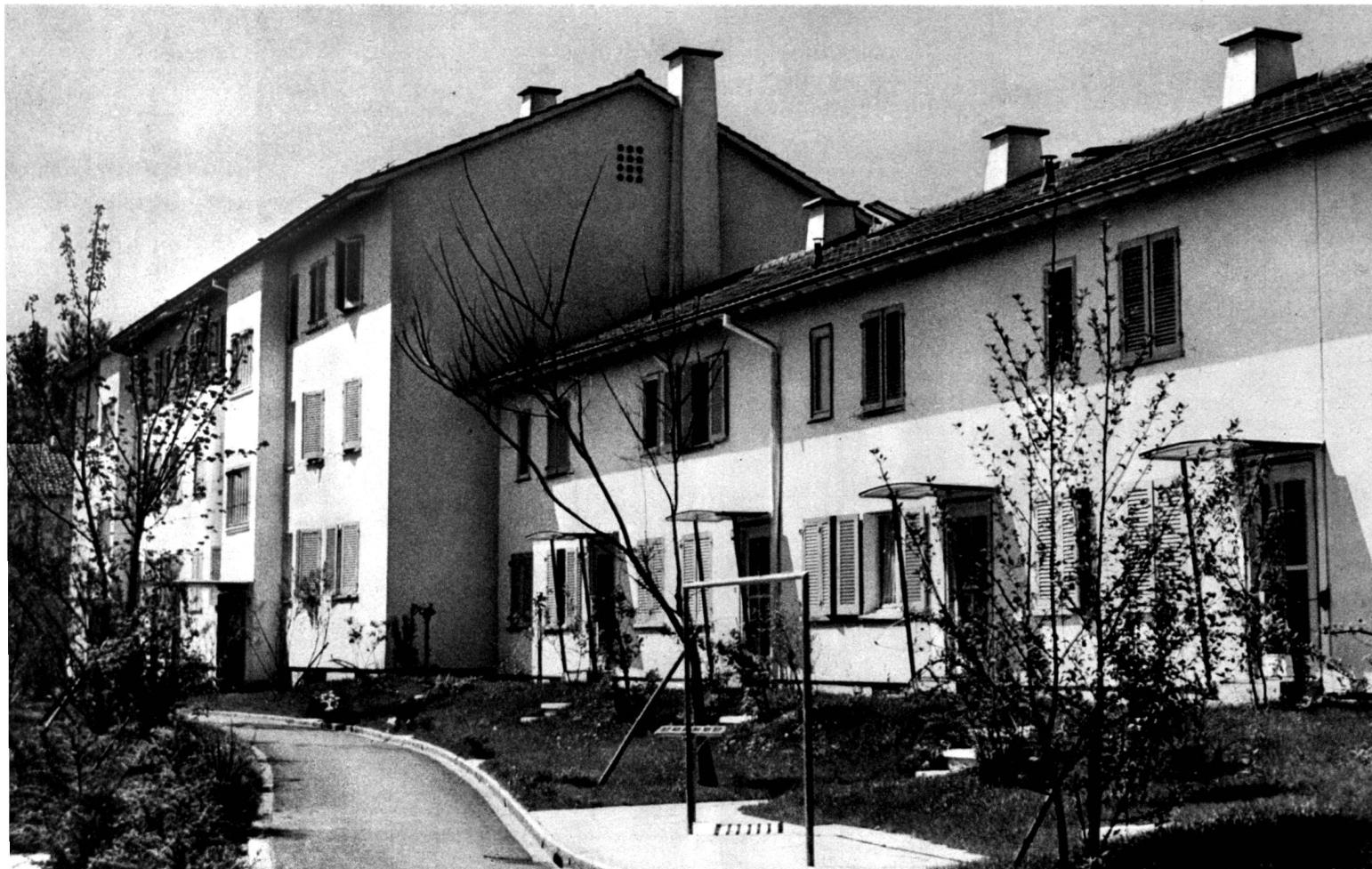
20. ASIG. Siedlung/Colonie Am Glattbogen, Zürich 11/Schwamendingen. Arch. : A. F. Sauter & A. Dirler, Zürich (1950/51).
