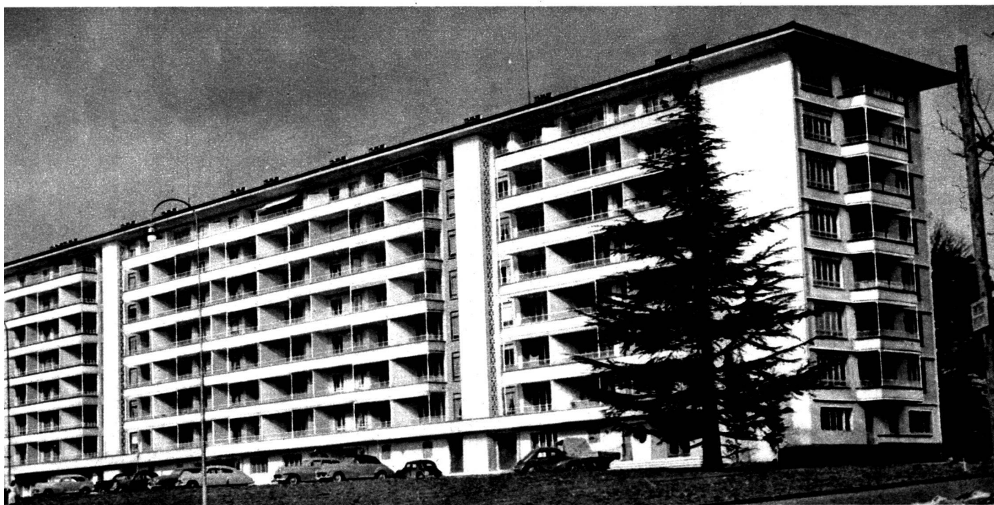
Société coopérative Graphis. Bloc II. F. Jenny et Honegger Frères, architectes. Genossenschaft « Graphis ». Block II. Architekten: F. Jenny und Gebrüder Honegger.
