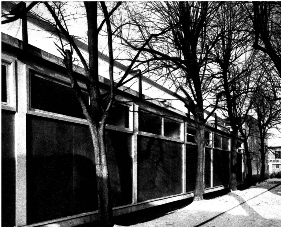
▼ Façade des vestiaires.
