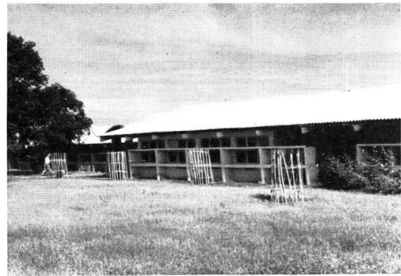
Bureau des architectes, où travaillent Pierre Jeanneret, et, momentanément, Le Corbusier.
