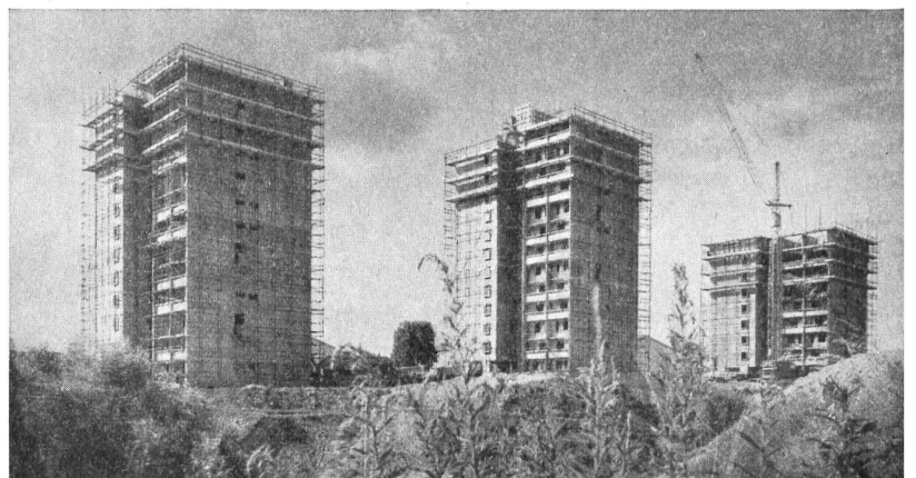
Le chantier en 1957, vu du sud.
