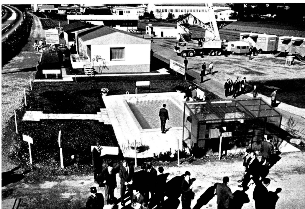
Trois vues des extérieurs
