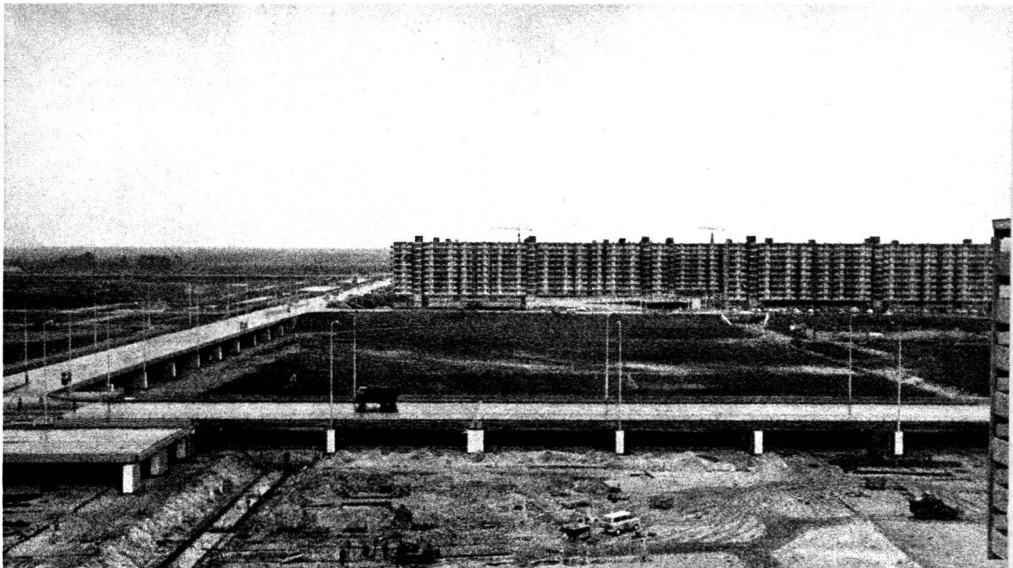
Bijmelmeer-Amsterdam, le début des réalisations esquissées par les maquettes de la page précédente : en bas : seule originalité de ces ensembles, de véritables rues intérieures relient les garages collectifs aux cages d'escaliers des immeubles : on y parcourt jusqu'à 400 mètres.
