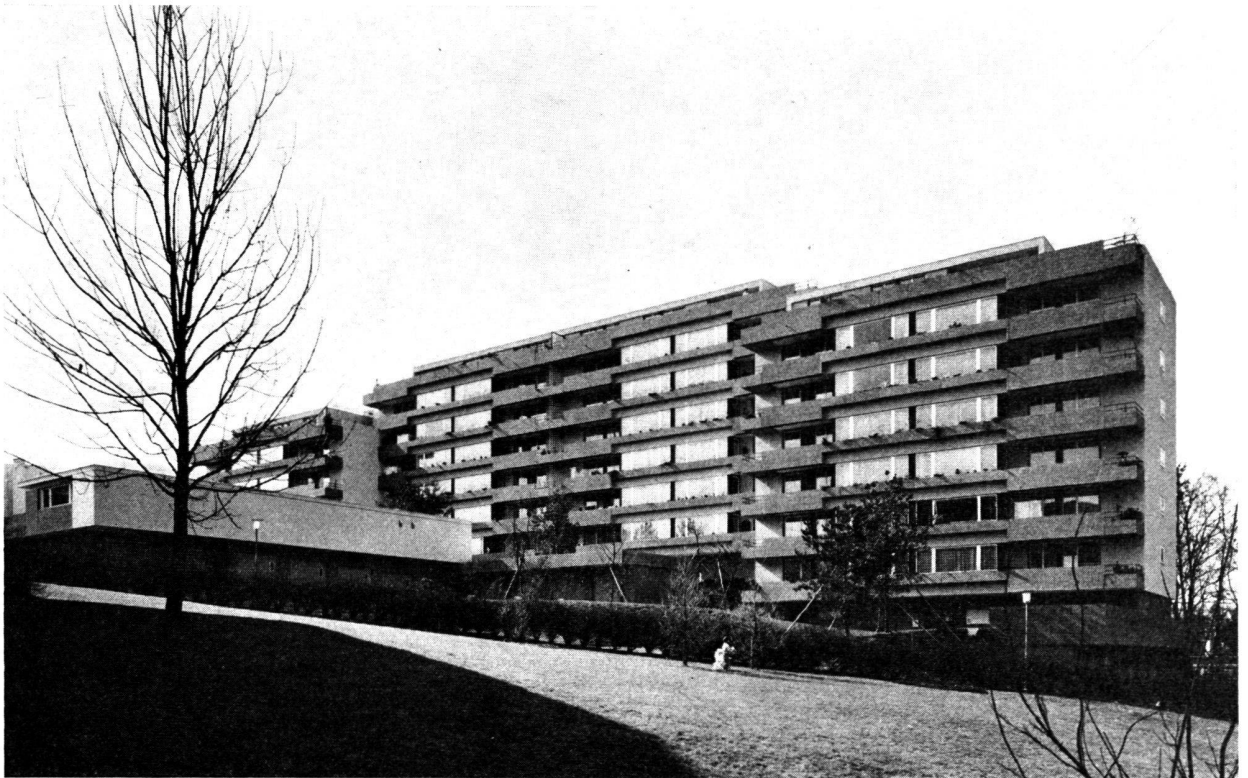
Vue extérieure du complexe immobilier « Chessel », à Schaffhouse. Chaque appartement comprend sa propre installation de chauffage à gaz. (Photo Koch, Schaffhouse.)
