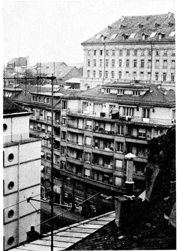
Fig. 32. Etat actuel (prise de vue du même endroit que dans la photo précédente). La région «décalée» a subi un «ajustement» par la construction de la rue Centrale en 1940-1947.
