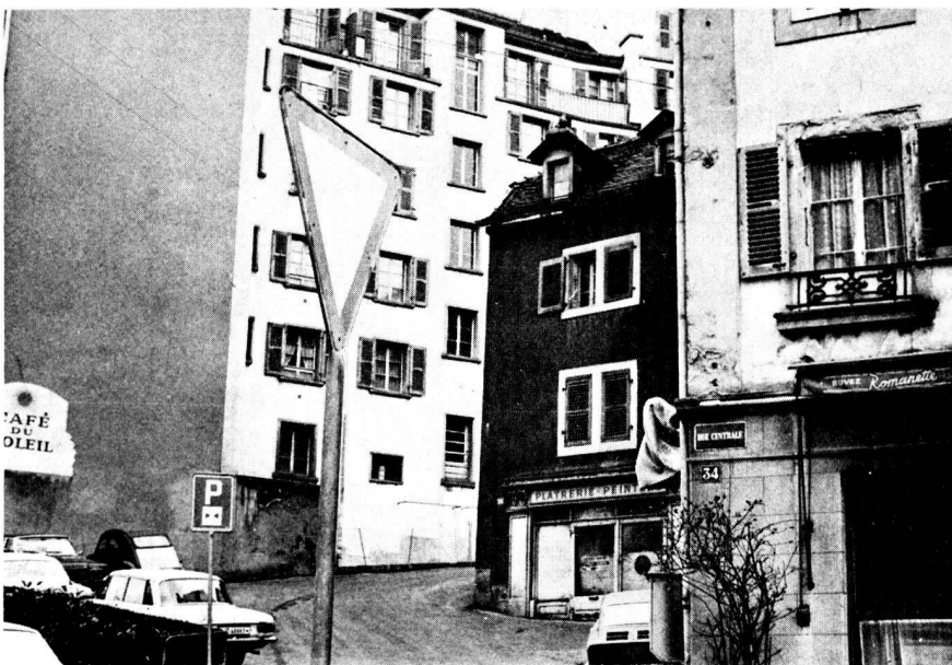
Fig. 62. Etat actuel (prise de vue du même endroit que dans la photo précédente). La Cheneau-de-Bourg a été transformée par des opérations d'assainissement en 1931-1937. A gauche, la façade arrière du premier des quatre immeubles de «Logement salubre».
