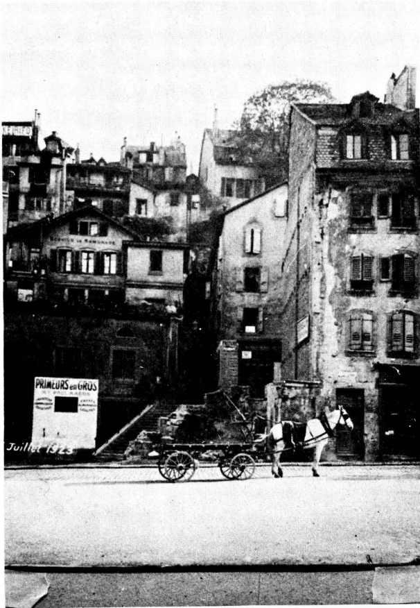
Fig. 46. Départ des escaliers des Petites-Roches, depuis la rue du Pré (1923). La photo est prise quatorze ans après l'incendie de la maison bernoise (fig. 21), dont on voit encore les décombres.
