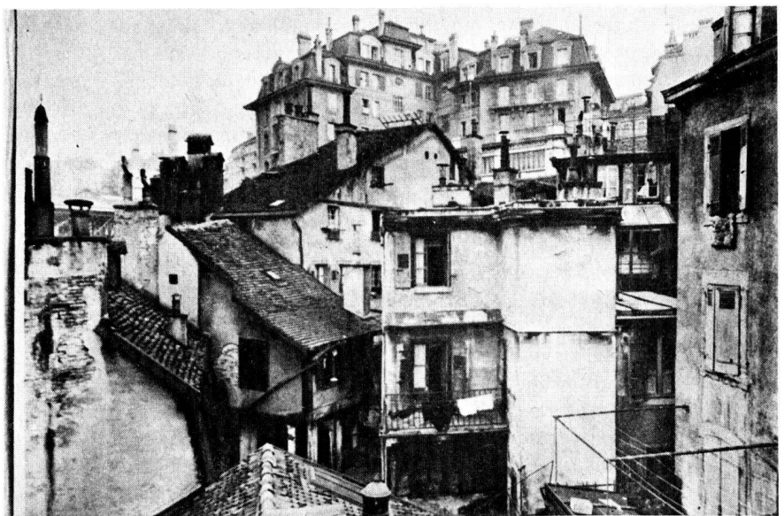
Fig. 38. Cours intérieures de la Cheneau-de-Bourg . Vue prise probablement juste avant la démolition en 1935. Au deuxième plan, immeuble moderne de la SI Colisée-Faucon SA. «On ne saurait plus concevoir, dans l'état actuel de nos idées sociales, une ville assemblant sans réagir les somptueuses maisons des riches et les taudis des malchanceux.» ( Histoire de la Construction à Lausanne , II, p. 17, 1942.)
