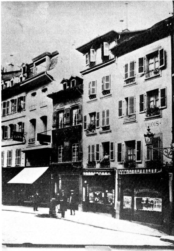
Fig. 36. Rue de Bourg . Maison d'angle de la Cheneau-de-Bourg, probablement vers 1940.
