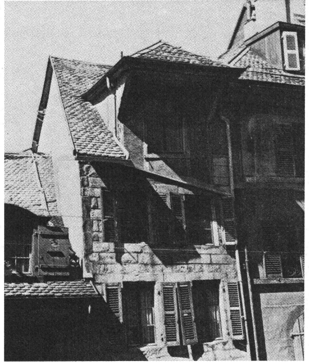
Façade (1 er , 2 e et 3 e étage), rue Beauregard N o 7.
