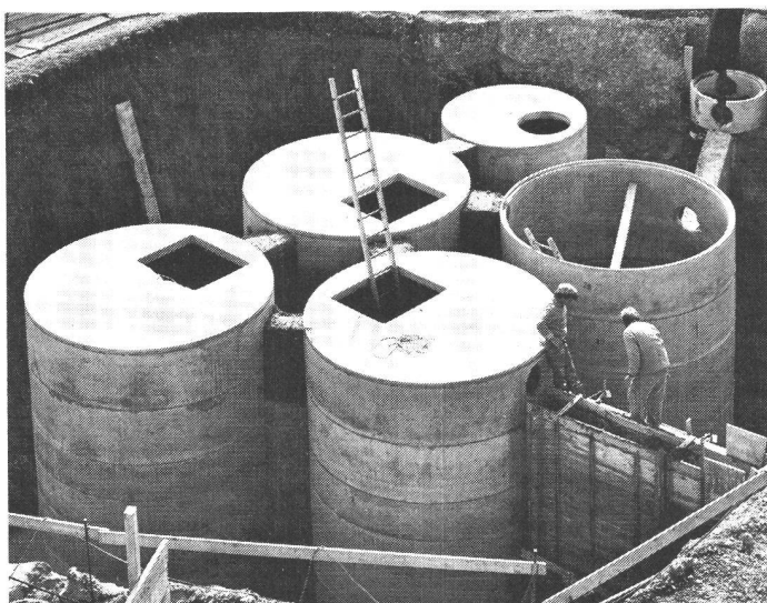
Construction d'une station d'épuration biologique Friwa dans le canton de Schaffhouse.
