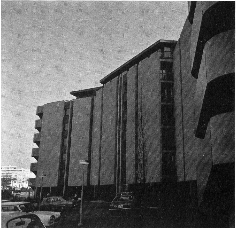
La façade nord de l'immeuble social et de l'hôtel maternel de Malley-Prairie. Architecte: Pierre Grand. Voir à ce sujet l'article en page 21.
