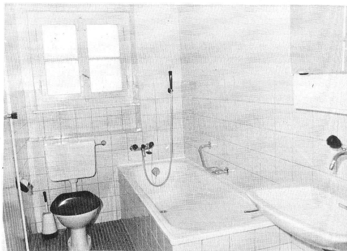
Salle de bains: avant et après rénovation
