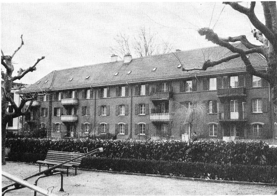
10.11 Logements construits par la Société Coopérative de la maison Ouvrière au Pré-d'Ouchy chemin Auguste-Pidou. Architecte R. Bonnard, 1921.
