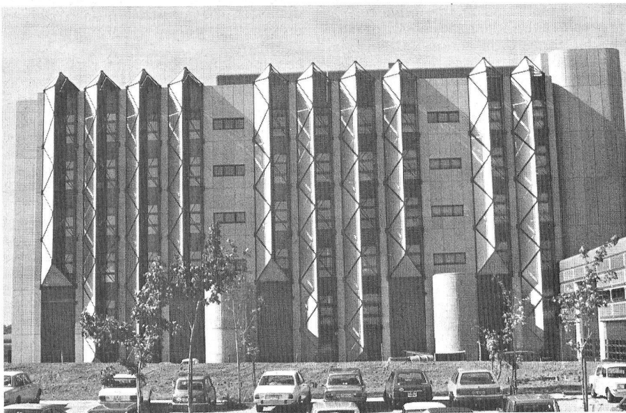
Façade Est du bâtiment de chimie (en service).
