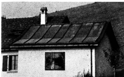
Capteurs actifs plans (27 m 2 ) intégrés sur la toiture d'une dépendance d'une villa à Belmont. (Photo: Antipas/Briner.)
