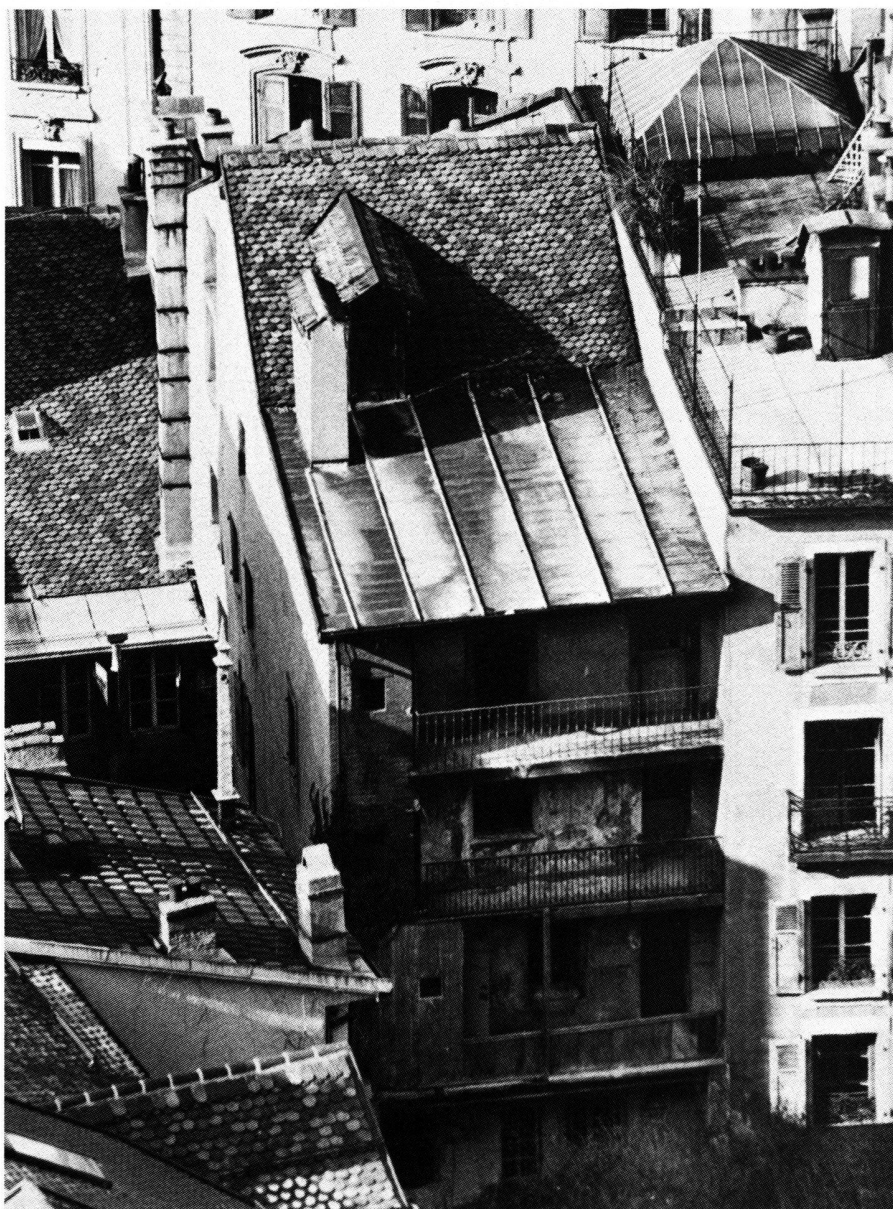
Façade est, sur jardin, avant la rénovation
