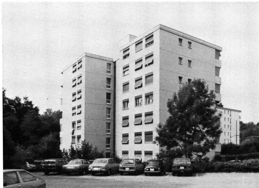
1975, 28 logements à Chavannes-près-Renens.
