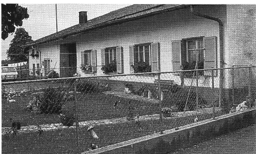
Transformation de façade aux Genevez. Les nouvelles fenêtres sont plus larges que hautes.
