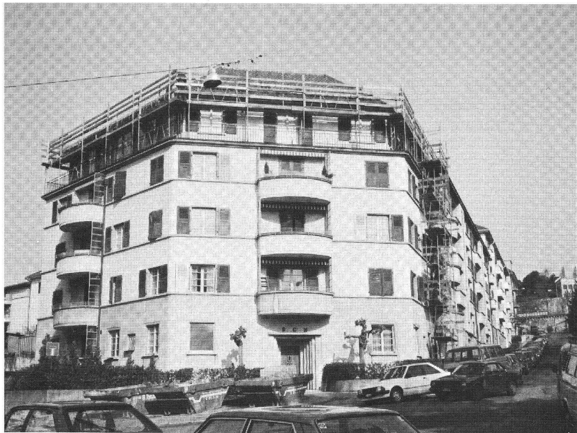
Bâtiments en rénovation au ch. de Fontenay, à Lausanne (mars 1986).
