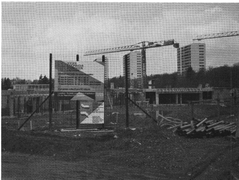
Bâtiments en construction à la Grangette-Sud, à Lausanne (avril 1986).
