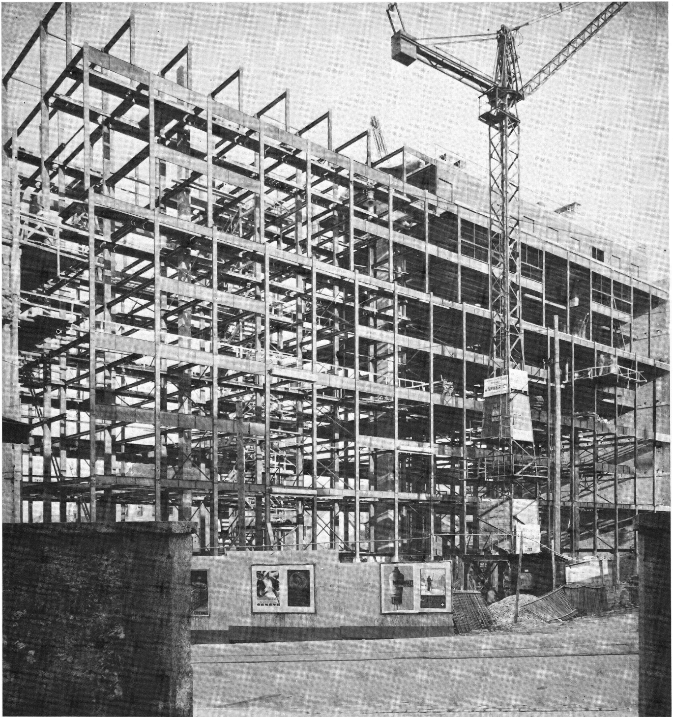
Ossature métallique, côté sud, 1931. (Photo Archives du Vieux-Genève.)
