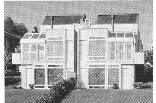
Fig. 1 – Habitations solaires à Bellerive, Lausanne. (Photo F. Presse/T. A. Woog)
