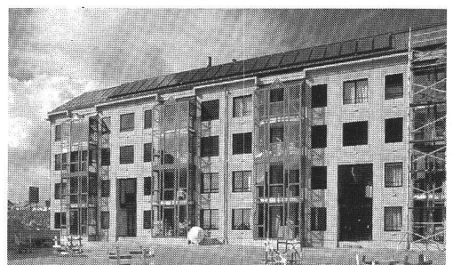
Fig. 21 – Bâtiment A, vue sud.
