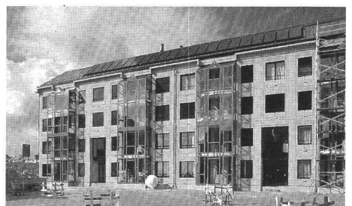
Fig. 21 – Bâtiment A, vue sud.
