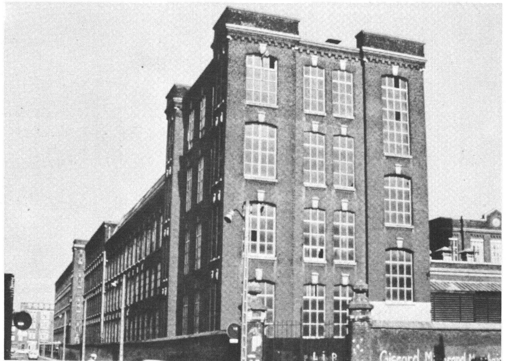
Filatures Le Blan à Lille, transformées en logements.
