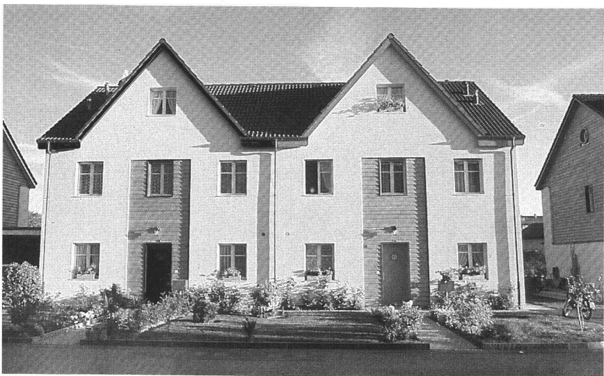
Fig. 12 – Façades sur rue.
