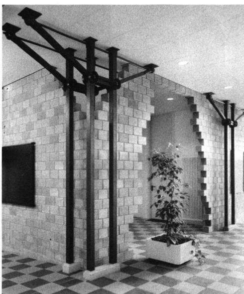
La nouvelle structure porteuse.
