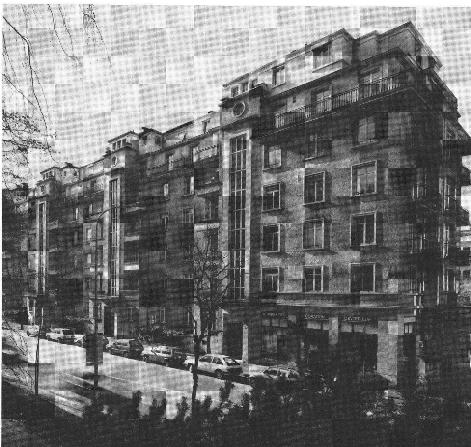
Vue de la façade nord.
