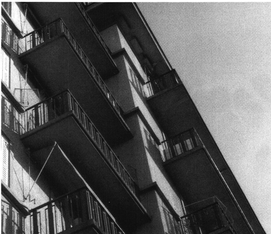
Vue des balcons de la façade sud.
