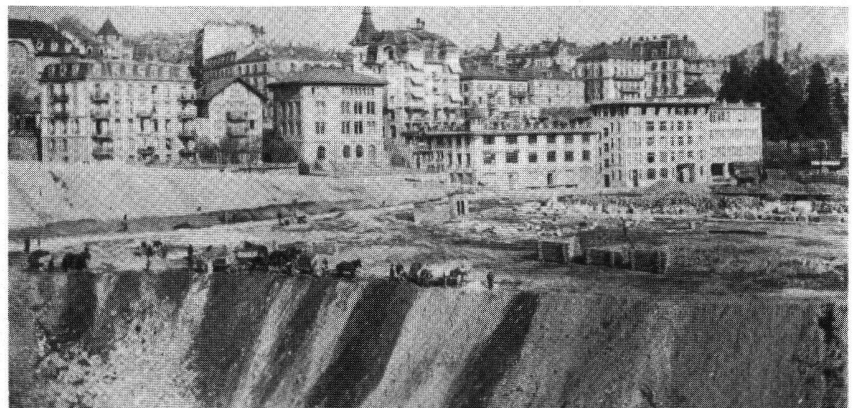
Les remblais proviennent tout d'abord du percement du tunnel et des tranchées de la ligne de chemin de fer, puis des divers chantiers en ville; la plate-forme sert également de décharge publique.
