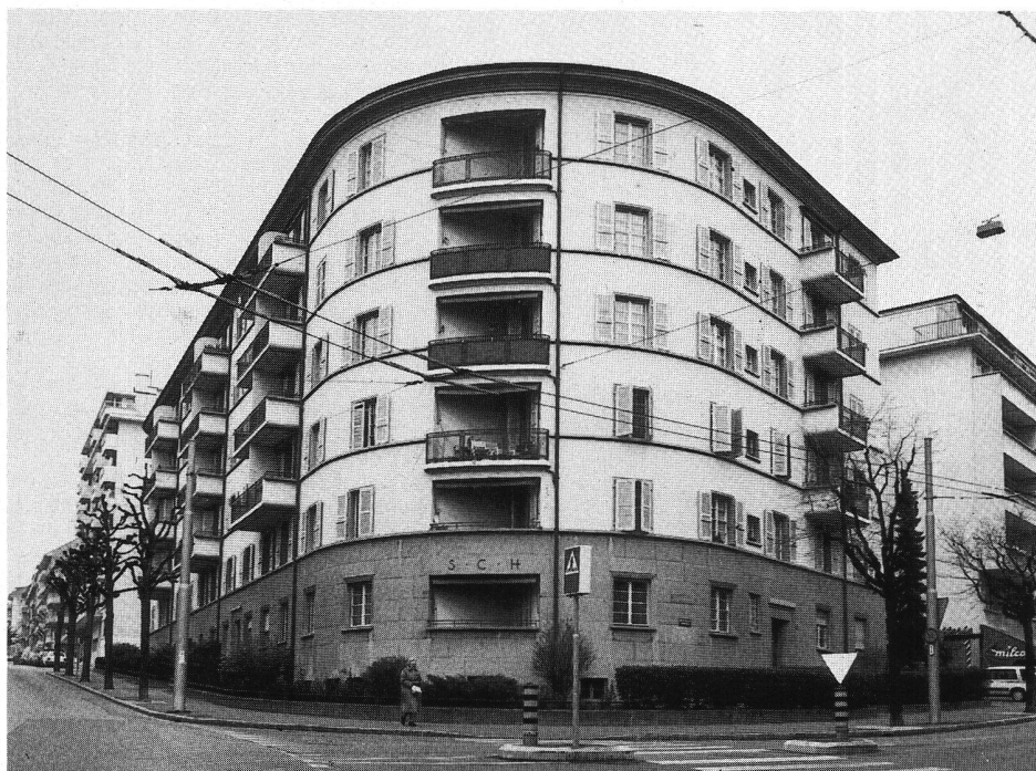
Vue de l'angle arrondi et des loggias côté sud.
