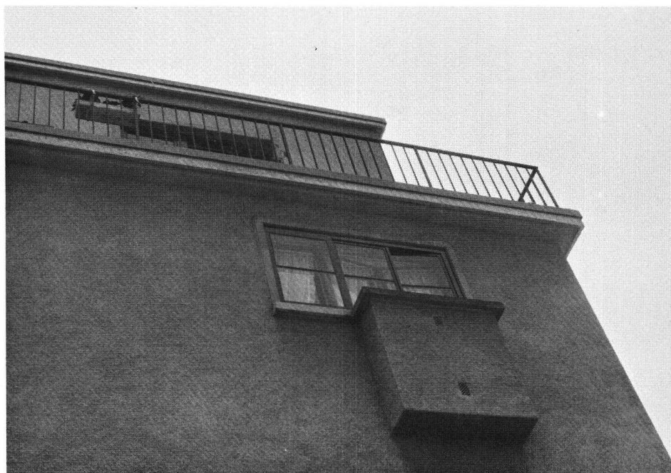
Vue du balcon des cuisines
