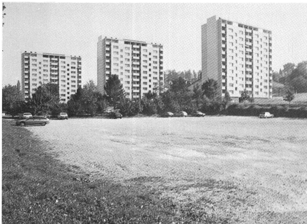
SOLIDARITÉ, Coopérative d'habitation, Fribourg, route du Jura, 3 immeubles d'habitations collectives subventionnées
