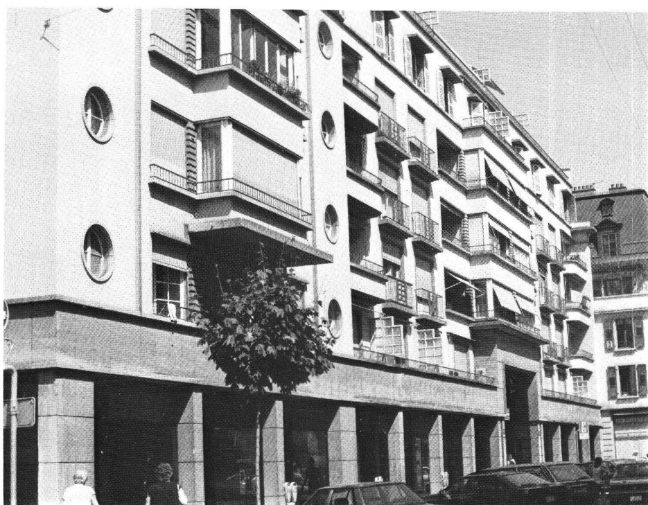
Vue de la façade sud
