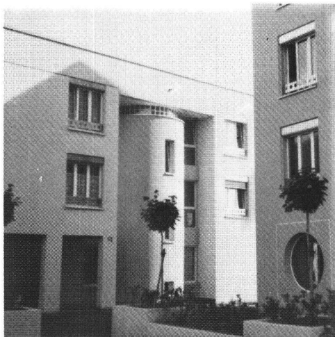
3000 logements ont été construits par les coopératives l'année passée. Ici, la fondation Pro Habitat à Lausanne
