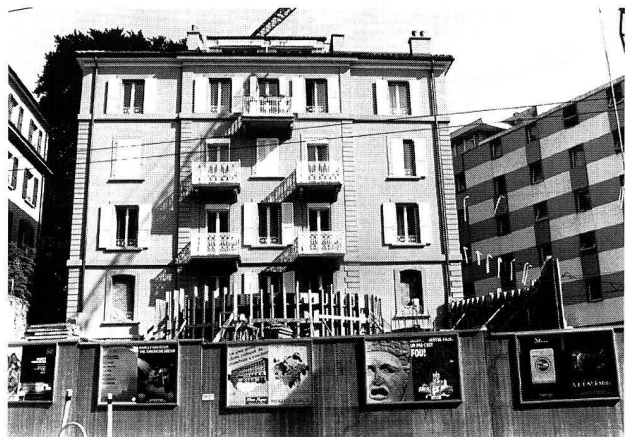
La réfection de l'immeuble est terminée. On construit une galette de bureau en surplomb de l'avenue Vinet
