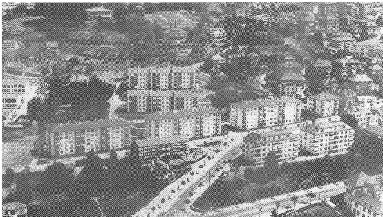
Vue générale du quartier du Mont d'Or au début des années cinquante. Les trois immeubles de la Coopérative FTMH et les deux «jumeaux» de Bon Abri sont bien alignés, au cœur de la photo (archives Coop FTMH).
