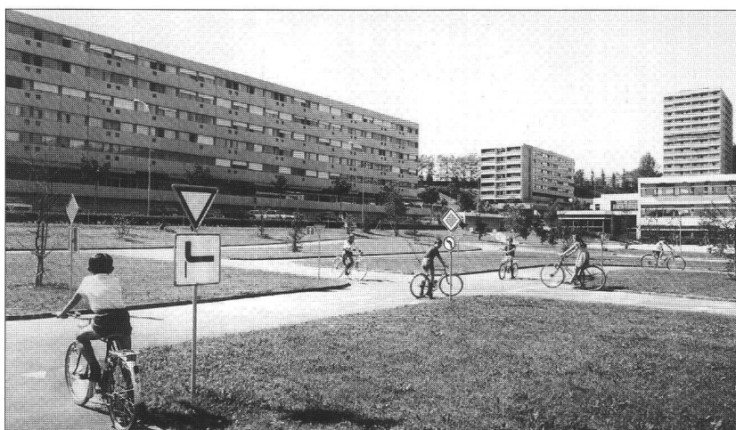
Vue depuis l'espace central (doc. Service Parc et Promenades, photo Vuillemin).
