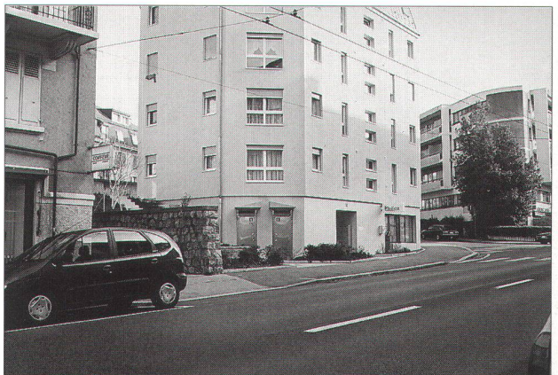
immeuble «Police» en retrait par rapport à la rue avec un espace de verdure résiduel de vant l'immeuble
